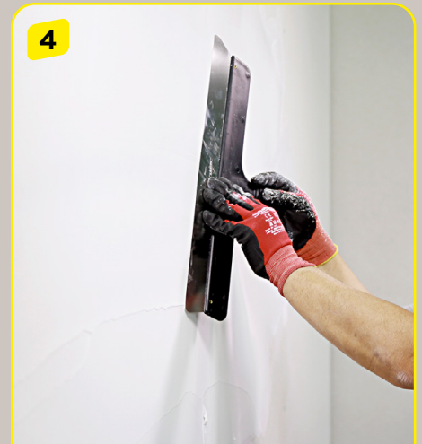
4 Anschließend die Spachtelmasse mit einem breiten Flächenspachtel abziehen, bis die Wand schön glatt ist.
